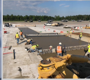
MCAS Camp Lejeune Mat Repair
